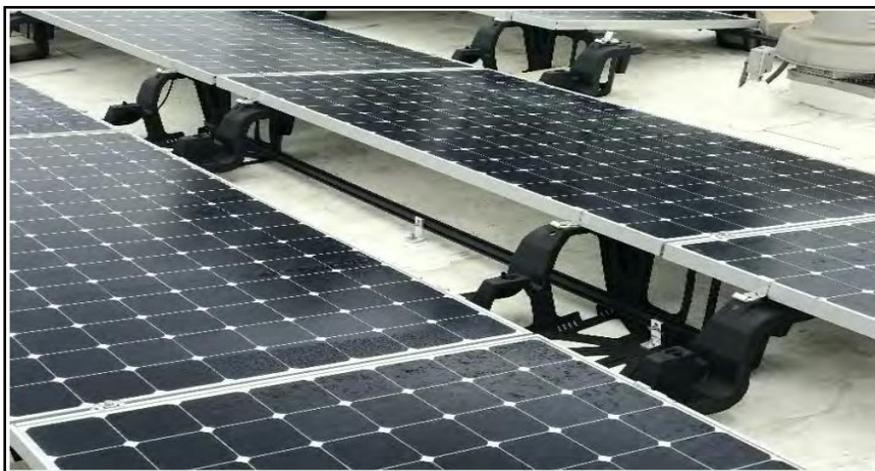
**Figura 4. Montaje del anclaje mecánico**
