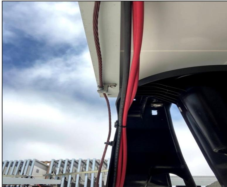
Figura 8. Clips de nylon para el cableado (FR-W-CLP)
